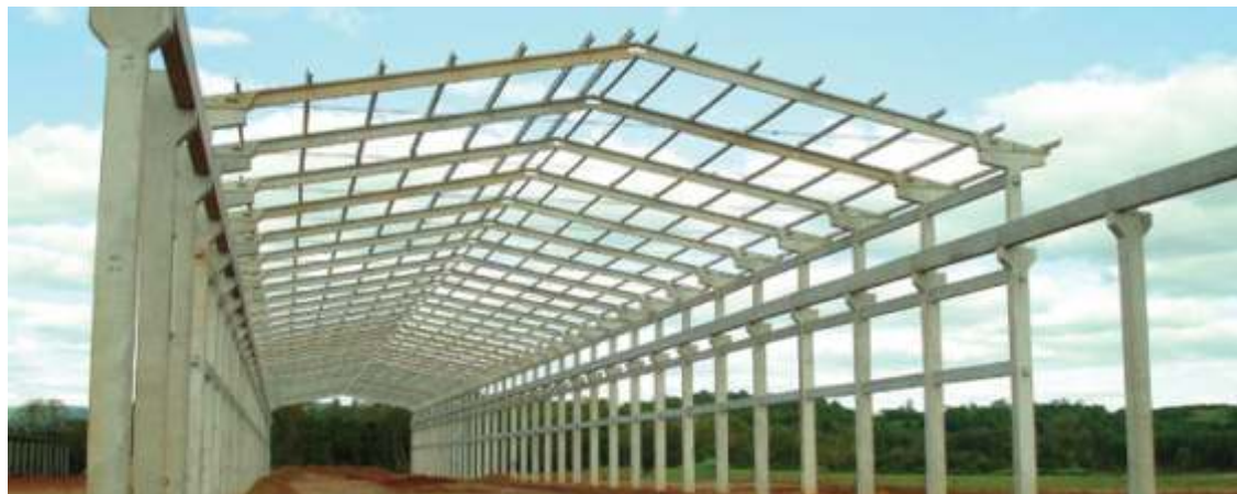
Estrutura de concreto pré-moldado
